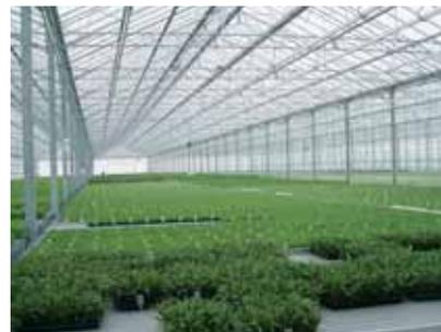
Corn. Bak BV, uno de los mayores productores y exportadores del mundo de plantas Bromelia, ha utilizado paneles de policarbonato Lexan ZigZag para renovar el techo de tres de sus invernaderos, lo que supone una superficie total de 3.800m<sup>2</sup>. La forma especial del panel de policarbonato de doble capa Lexan ZigZag vuelve a reflejar la luz en el invernadero, por lo que se consigue una mayor transmisión de luz que con el vidrio normal
